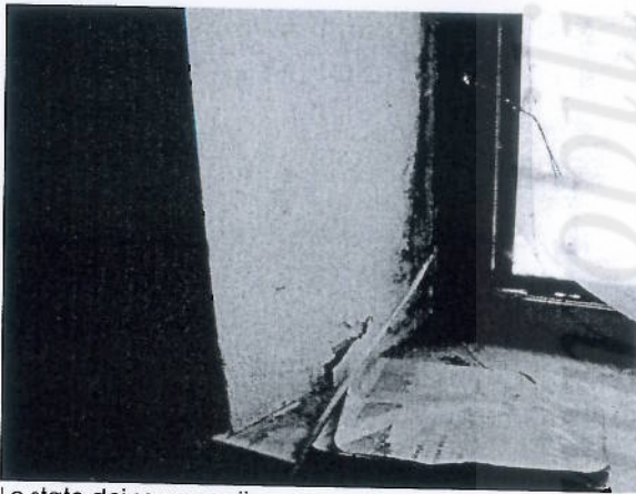
Lo stato dei serramenti
