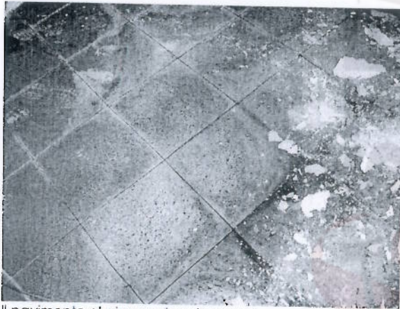
Il pavimento al piano primo (camera)
