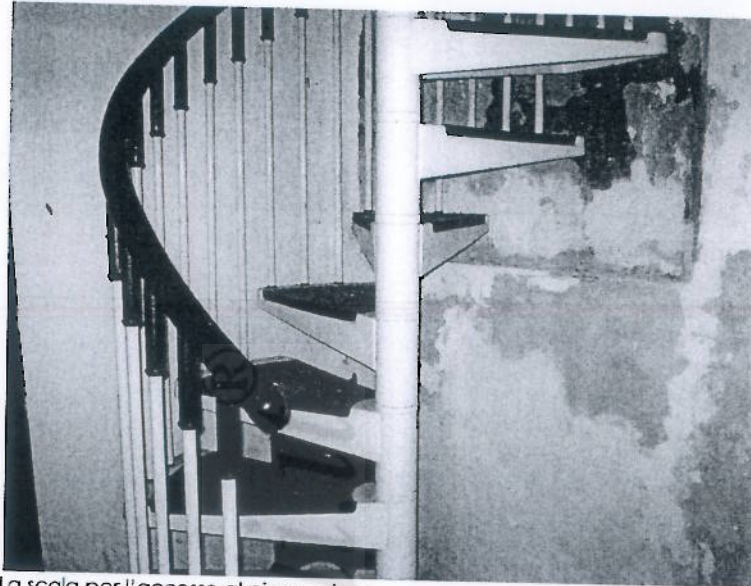
La scala per l'accesso al piano primo
